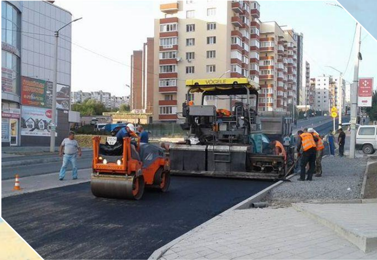
Ремонт та будівництво доріг 146,6 млн. грн.:
